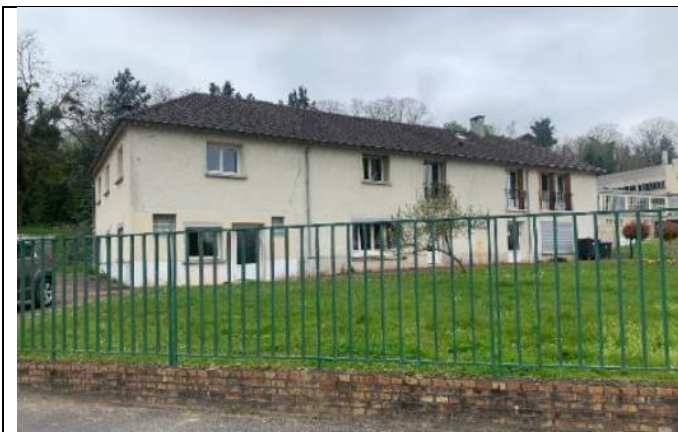
Bâtiment administratif de la DEA
