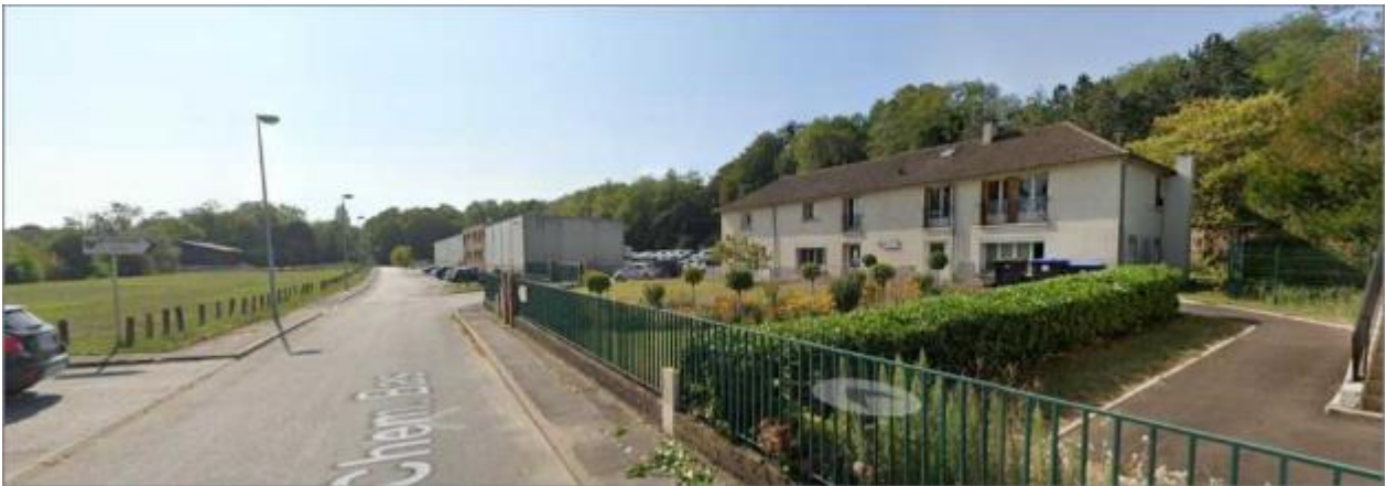
Bâtiments de la DEA : administratif et commercial
