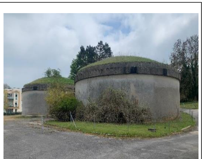
Réservoirs dits du bas service
