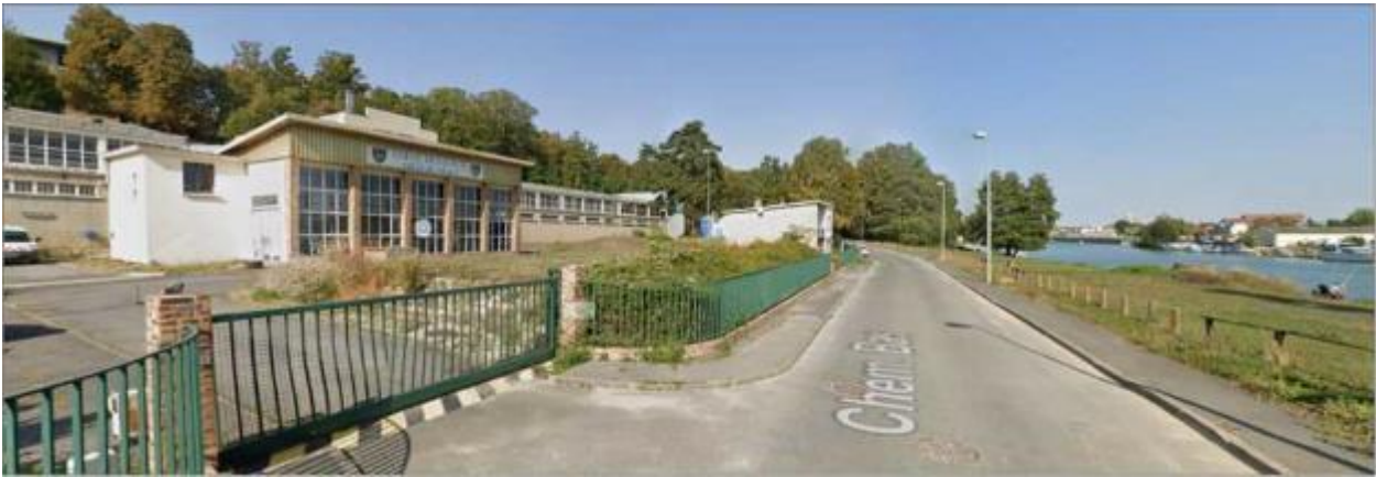
L'usine actuelle ( bâtiment bistre)
