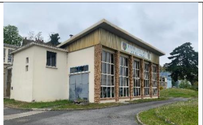
Usine proprement dite qui ne sera démolie qu'après mise en service de la nouvelle
